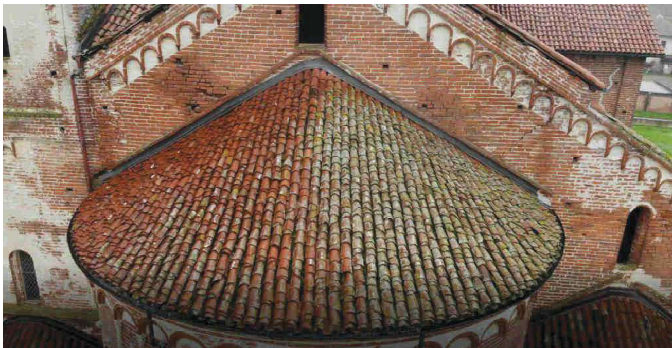
Foto 9 – dettaglio dell'abside della navata centrale; muffa tra i coppi sul lato di mezzanotte.
