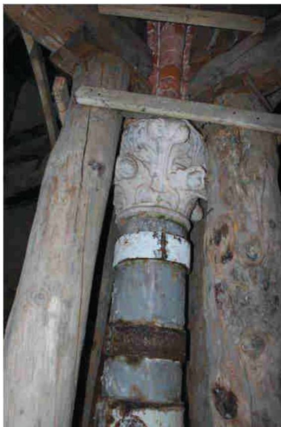
Foto 39 – stato di degrado dei pilastri e delle protesi/cerchiature metalliche aggiunte.
