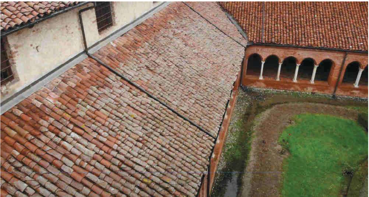
Foto 20 – tetto del chiostro di ponente; scivolamenti di coppi in gronda con affaccio sul giardino.
