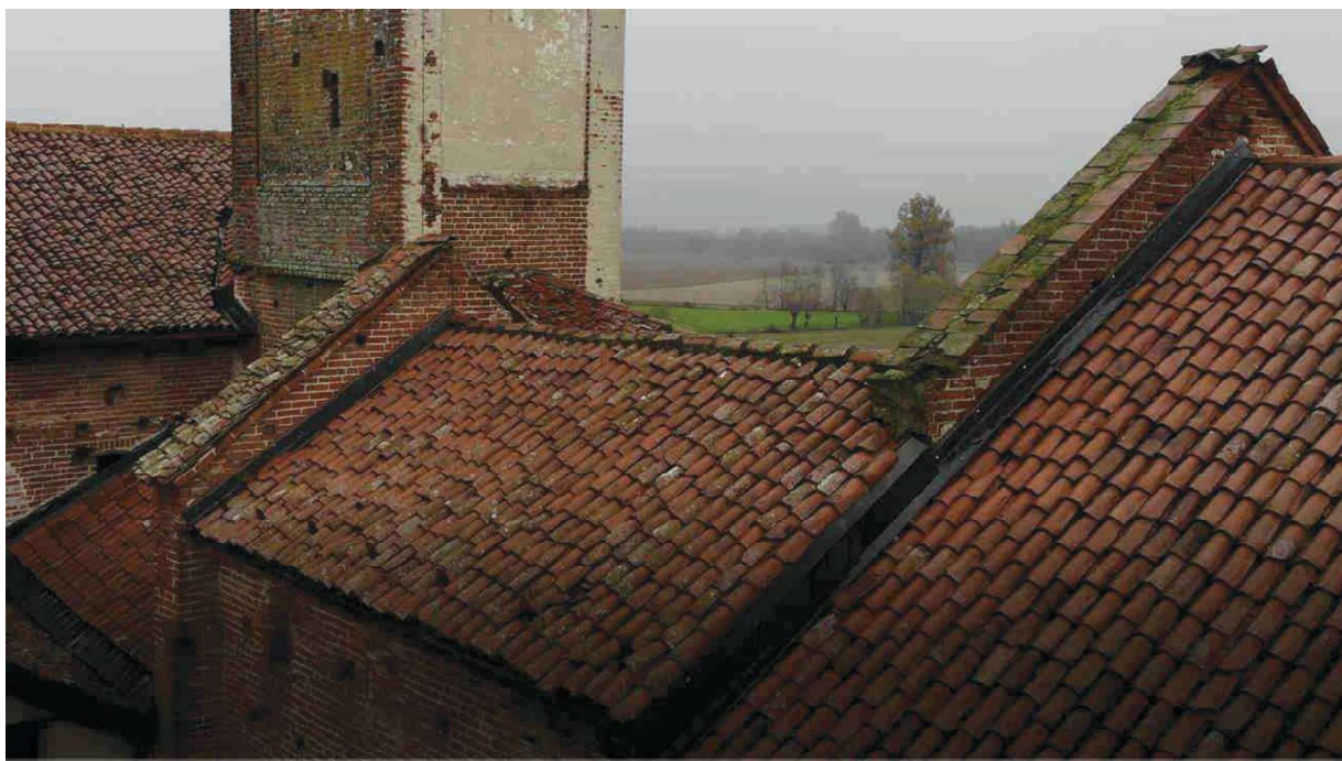
Foto 17 – viste da ponente del loggiato; coppi scivolati in gronda.
