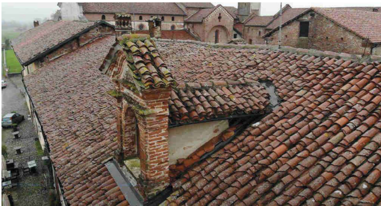
Foto 26 – dettaglio stato abbaini e camini.
