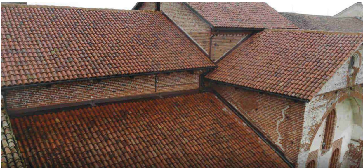
Foto 1 – parte delle falde a Nord Est della chiesa rifatti dopo i danni del nubifragio del 2014.
