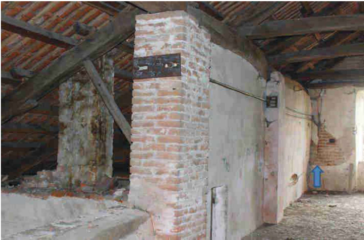
Foto 42 – timpano della facciata rivolta a mezzogiorno visto dall'interno; la freccia evidenzia la discontinuità del paramento murario di cui alla fessurazione esterna; sono visibili il sistema di tiranti metallici aggiunto e meglio illustrato come posizione dallo schema a seguire.
