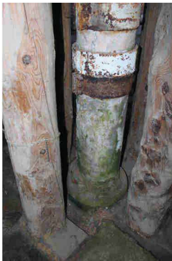
Foto 39 – stato di degrado dei pilastri e delle protesi/cerchiature metalliche aggiunte.
