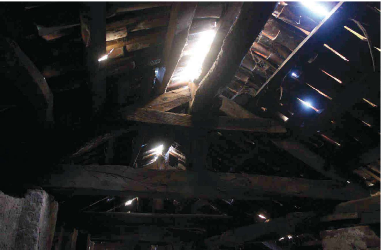
Foto 48 – numerosi varchi anche importanti nel manto di copertura.
