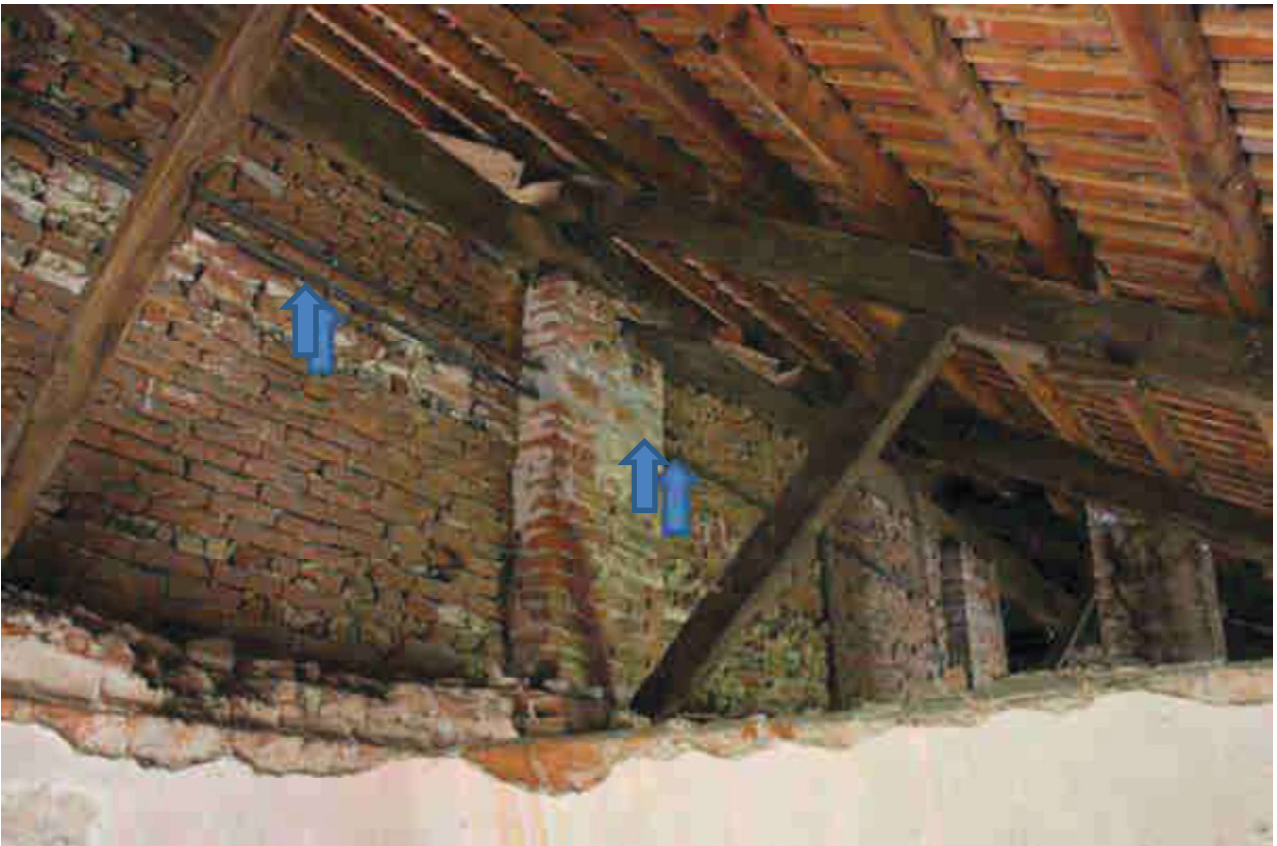
Foto 43 – tiranti metallici al livello superiore estesi in lunghezza su due campate e su entrambe le facce della parete; nella prima campate tirante raddoppiato; muro interno di levante.
