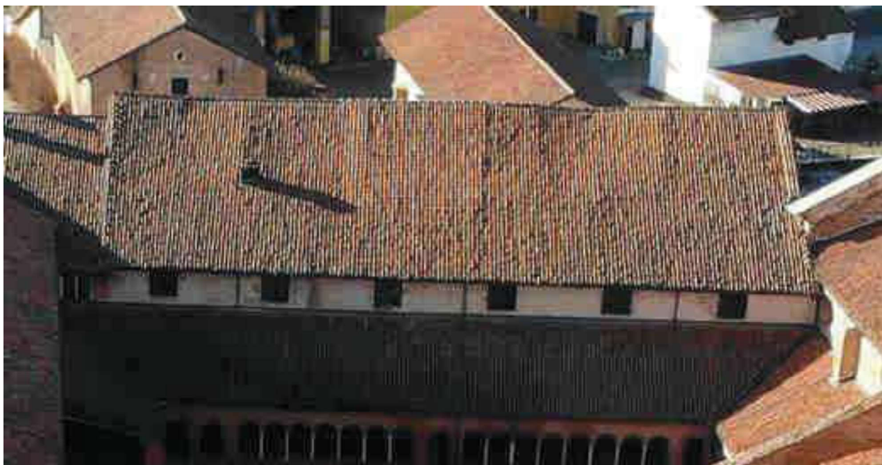
Foto 22 – vista di insieme da levante; con luce radente l'ondulazione della falda indice del disagio dell'ordito sottostante è evidente.
