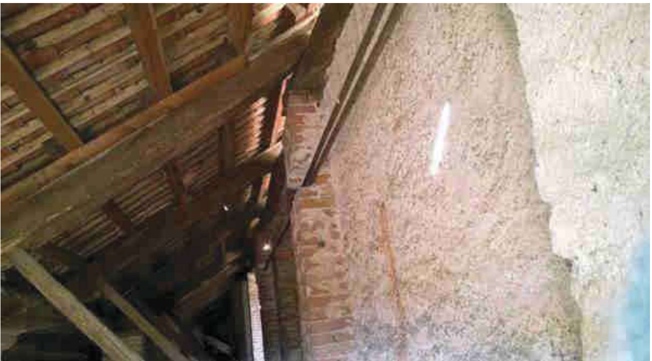
Foto 44 - tiranti metallici al livello superiore estesi in lunghezza su due campate e su entrambe le facce della parete; nella prima campate tirante raddoppiato; muro interno di ponente.
