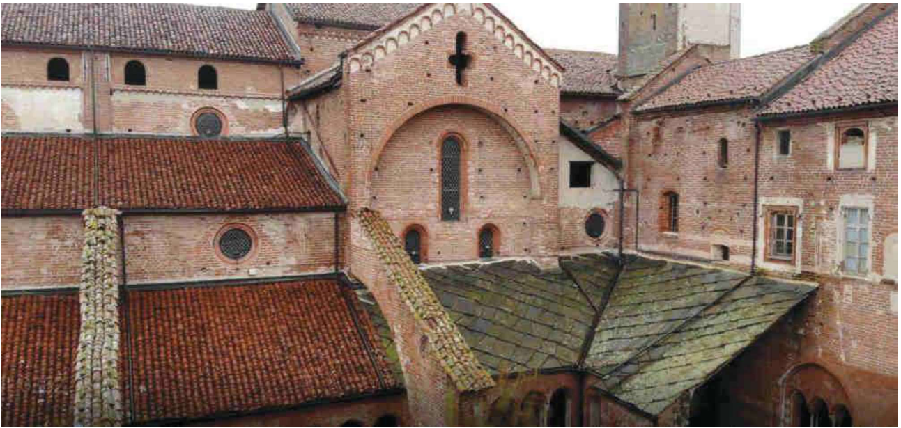
Foto 19 – vista del tetto del chiostro di mezzogiorno; in primo piano i due archi rampanti la cui risistemazione dei coppi è stata inserita nell'intervento di massima urgenza.
