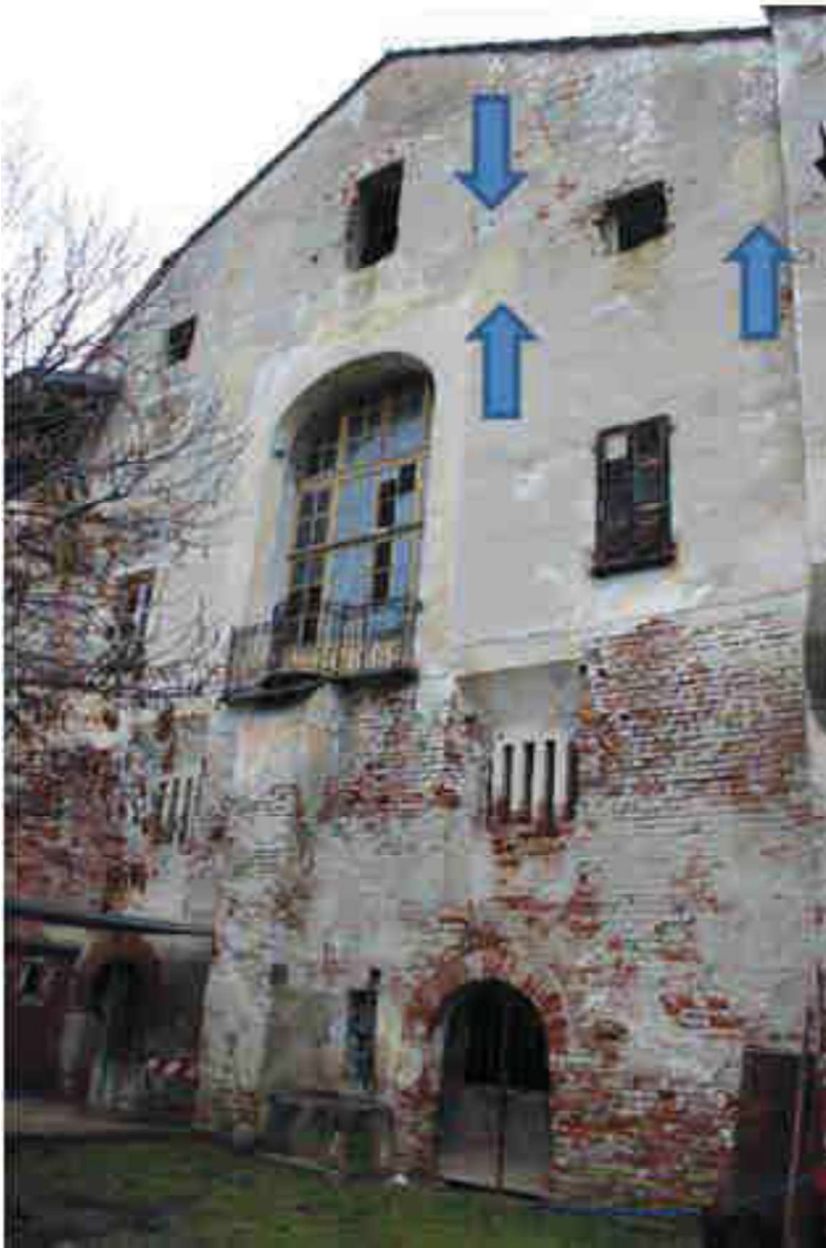
Foto 41 – corpo di fabbrica 1 testata rivolta a mezzogiorno; le frecce indicano le posizioni dei capochiave sotto traccia corrispondenti ai tiranti metallici disposti su due livelli e aggiunti a presidio del potenziale ribaltamento della facciata; sono riportati i riferimenti per il lato di sinistra; allo stesso modo ne sono presenti altrettanti sulla destra in posizione simmetrica rispetto al colmo.
